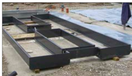
Einbaurahmen für Fahrflächenvarianten mit und ohne Bodenausgleich zum genauen Einpassen der Hebebühne. Durch die vorgefertigten Einfassungsrahmen wird hohe Genauigkeit beim Einbau erreicht.
